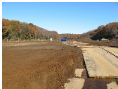
完成に向けて工事が進む志津霊園
